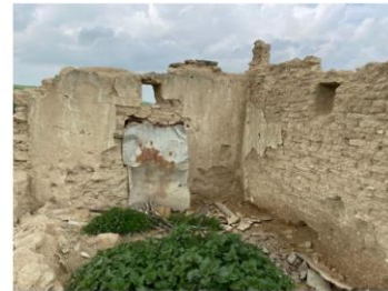
Εσωτερικός χώρος κτηρίου
