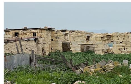
Σειρά πετρόκτιστων κτισμάτων
